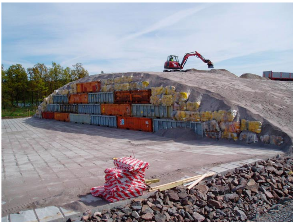
Figur 4-2. Exempel på markförvar för mycket lågaktivt avfall
