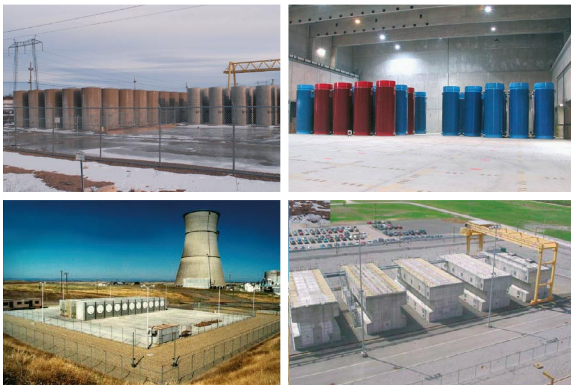
Figur 9-2. Exempel på anläggningar för torr lagring. Överst till vänster Utomhuslagring vid Point Lepreau Generating Station (Källa: NBPower Nuclear). Överst till höger CASTOR®-behållare i lagerbyggnad vid Gorleben i Tyskland (Källa: IAEA). Nederst till vänster NUHOMS® vid Susquehanna kärnkraftverk i USA (Källa: IAEA). Nederst till höger CANSTOR®-moduler vid Gentilly-2 i Kanada (Källa: Hydro Quebec).
